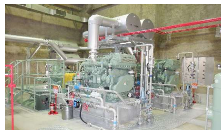
人吉市宝来雨水ポンプ場 ポンプ復旧 R4.5撮影
