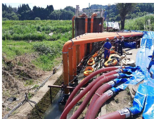
頭無川雨水ポンプ場 仮設ポンプ設置
