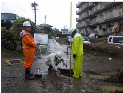
熊本市 管路調査
