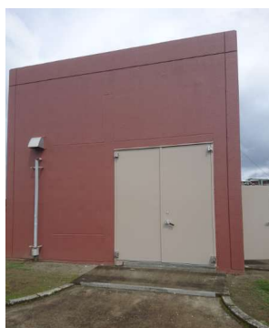
人吉市浄水苑 消毒棟 R4.5撮影
