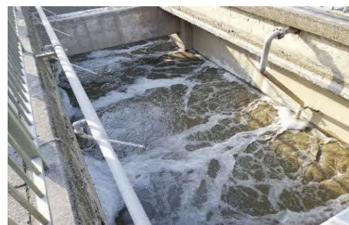
簡易的な生物処理(送風機仮復旧)
