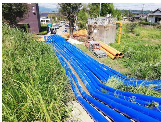
頭無川雨水ポンプ場 仮設ポンプ設置
