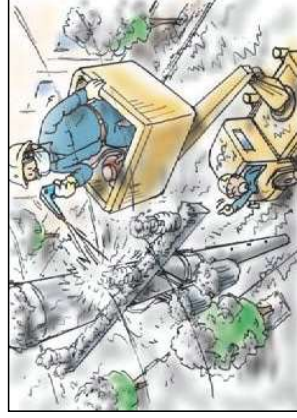
停電防止のため碍子等の清掃（降灰除去）が必要
