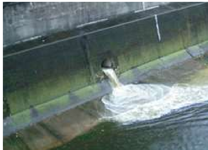
雨水吐口からの放流状況
