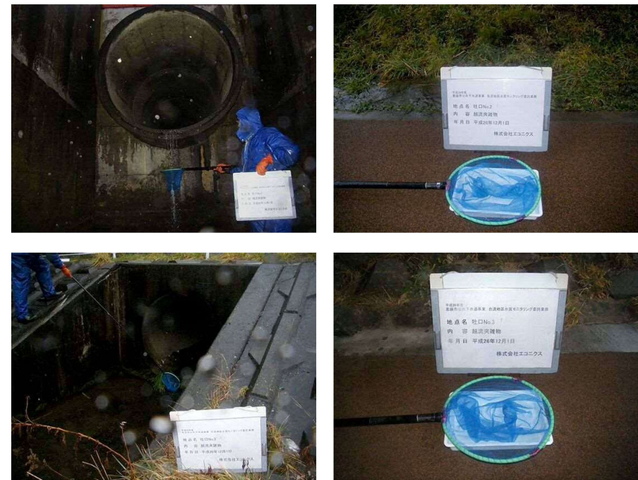
きょう雑物除去状況
