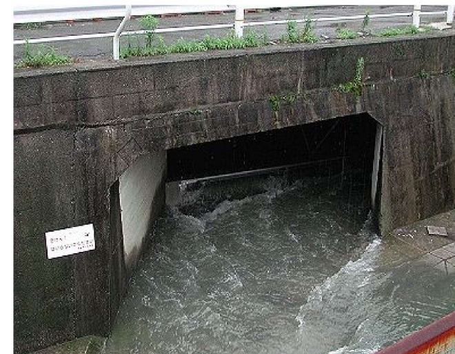
ろ過スクリーンを設置した吐口
