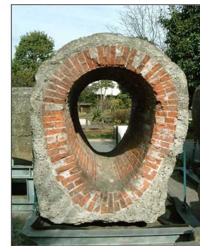
横浜市レンガ製下水管きょ (明治14年)
