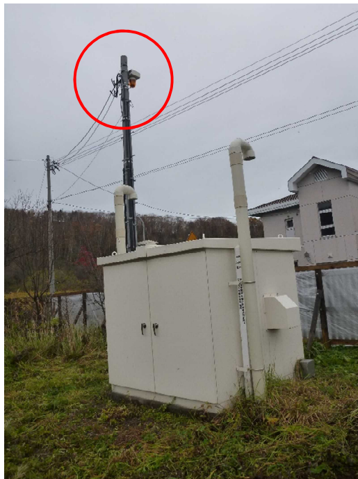
図 4-1 パトライト故障通報装置の例
