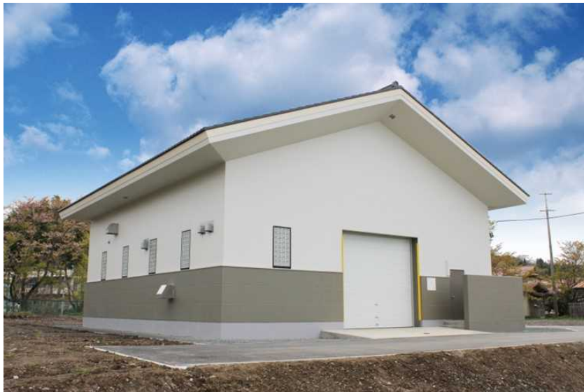
図 2-7 積雪対策としての建屋築造の例
