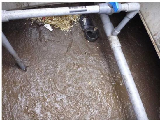
写真 4-2 汚泥濃縮貯留槽におけるスカムの異常発生状況例
