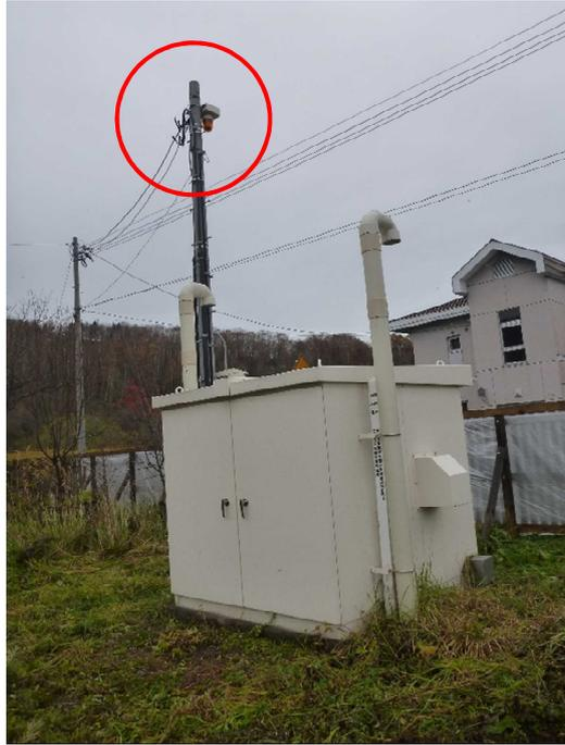
写真 4-3 パトライト故障通報装置の例
