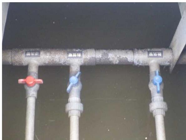
写真 4-1 接触曝気槽内の空気配管系統の分岐弁例
