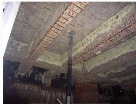
腐食が進行し鉄筋露出
