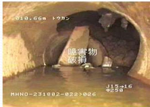
破損した管路
