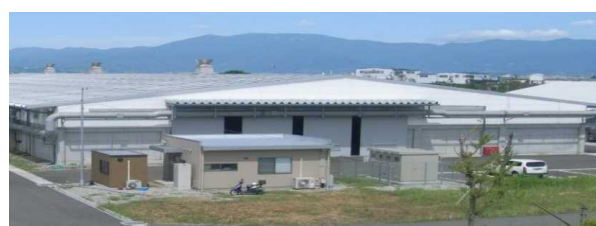
汚泥堆肥化施設 (外観)
