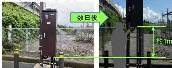
26 制御盤を上げる前
