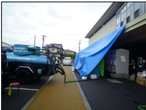
避難所でのし尿くみ取り作業
