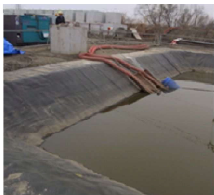
汚水ポンプ場(停止中)付近で簡易沈殿・消毒処理の後、本川まで導水して放流
