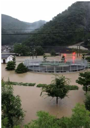
美袋浄化センターの浸水状況（総社市）
