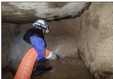
管路内土砂除去状況 (広島市)
