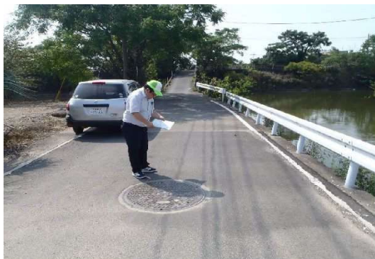
(13) 緊急点検状況(管渠・MH)
