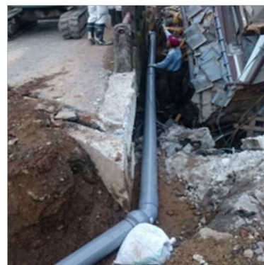
橋に仮設管懸架（露出）
