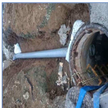
別幹線MHへ仮設管を布設
