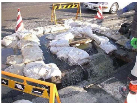
土のうを用いて近傍の側溝への消毒放流状況
