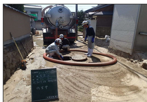
管路内土砂除去状況 (広島市)
