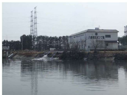
仮設ポンプによる排水
