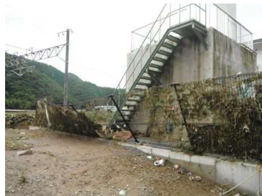
広瀬雨水ポンプ場の被災状況（高梁市）
