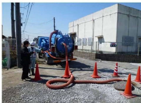
汚泥吸引車による吸引状況
