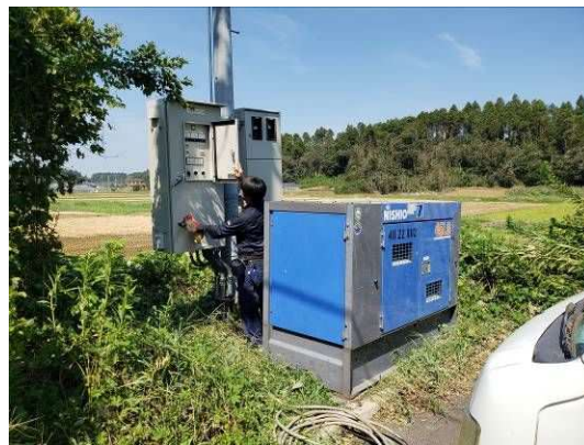
可搬式発電機設置作業（マンホールポンプ）
