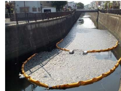
スカムの状況① (R1. 6. 25 双流橋下流)
