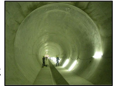
堀川右岸雨水滞水池
