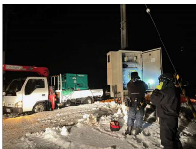
図 4-4 トラックに積載した可搬式発電設備巡回の様子（北海道紋別市）
