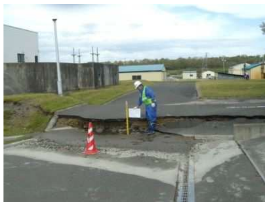
鶴川終末処理場内の地盤沈下
