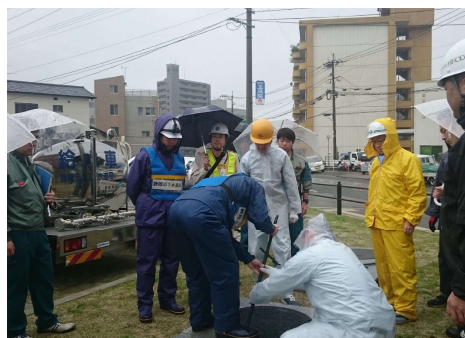
デモンストレーション （マンホール蓋開閉方法）
