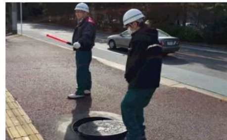
⑤緊急点検・調査(ポンプ場)
