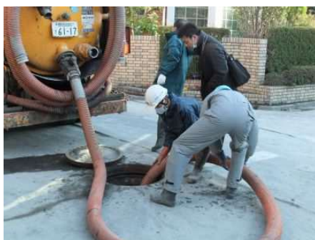
管路施設の調査だけでなく、業者手配から指揮系統まで全面的な支援を受けた（浦安市）
