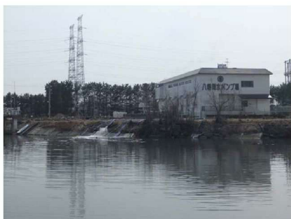
仮設ポンプによる排水
