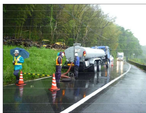
流域下水道マンホールへし尿投入
