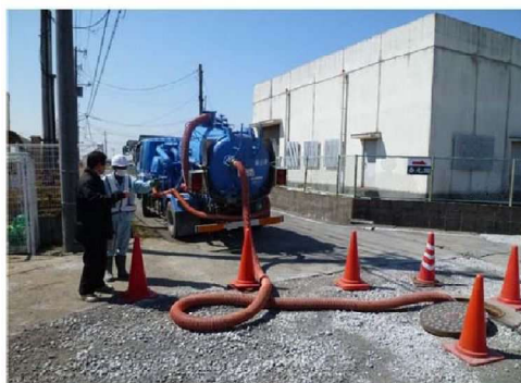
汚泥吸引車による吸引状況
