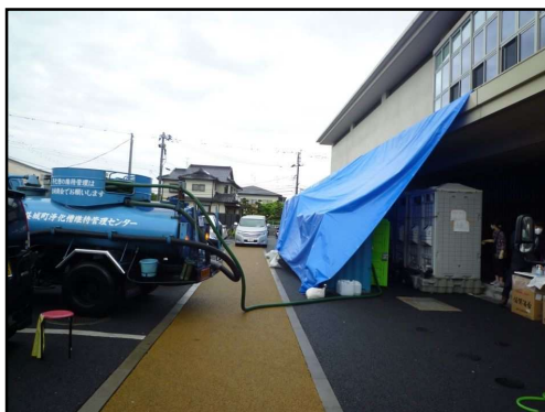
避難所でのし尿くみ取り作業
