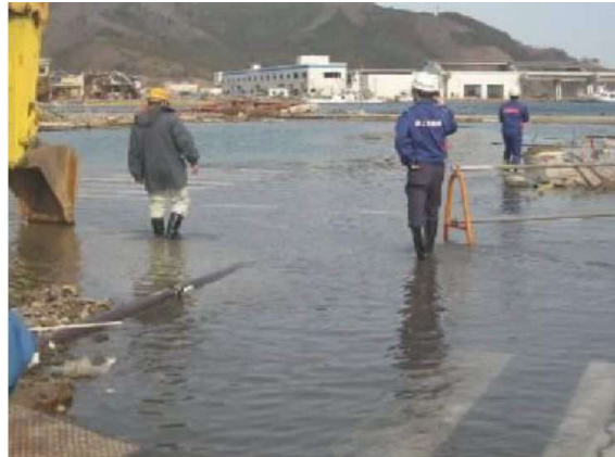
被害状況の確認（女川町）
