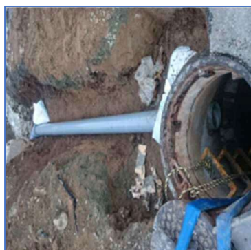
別幹線MHへ仮設管を布設
