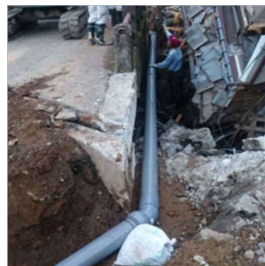
橋に仮設管懸架（露出）
