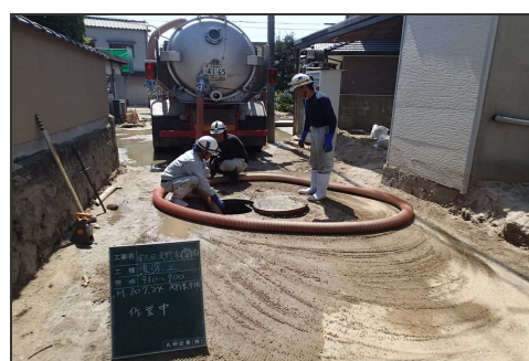
管路内土砂除去状況 (広島市)
