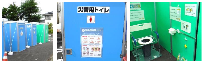
マンホールトイレ
