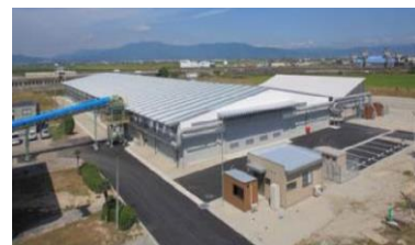
汚泥コンポスト化施設
