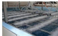
超微細散気装置導入による省エネ化 (〇〇t-CO 2 削減)
