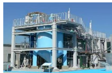
リン回収施設
