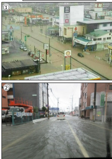
平成30年7月浸水状況
