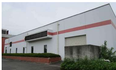
①雨天時貯留池の整備
