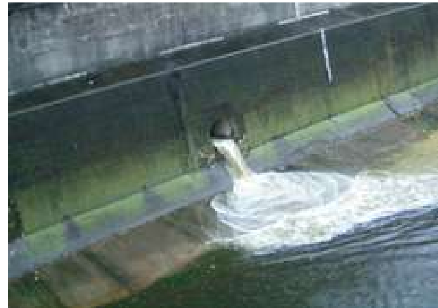
雨水吐口からの放流状況
