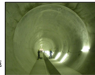
堀川右岸雨水滞水池
