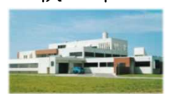
汚泥再生施設
