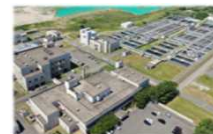
処理センター
