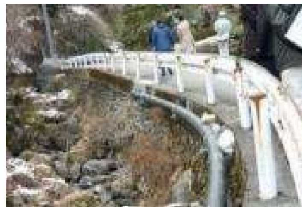
クイック配管 （露出配管）
