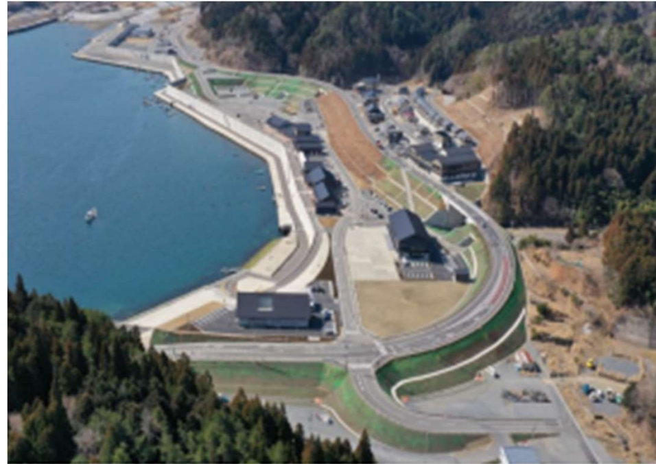
下水道から浄化槽への転換例 石巻市雄勝地区(東日本大震災)
