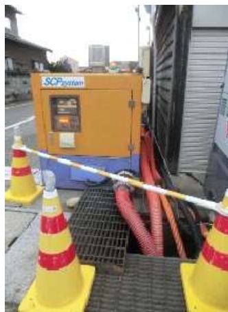
真空式仮設排水管の設置(羽咋市)
