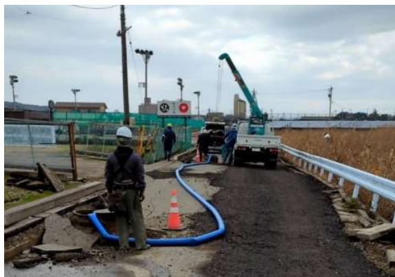
仮設排水管の設置(七尾市)
