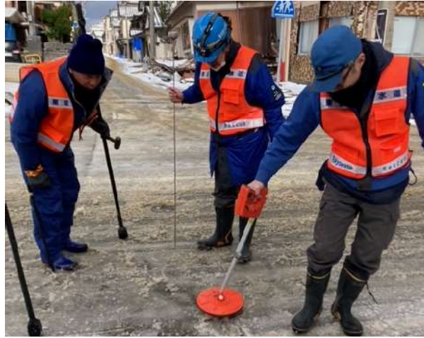
輪島市漏水調査 (東京都水道局)
