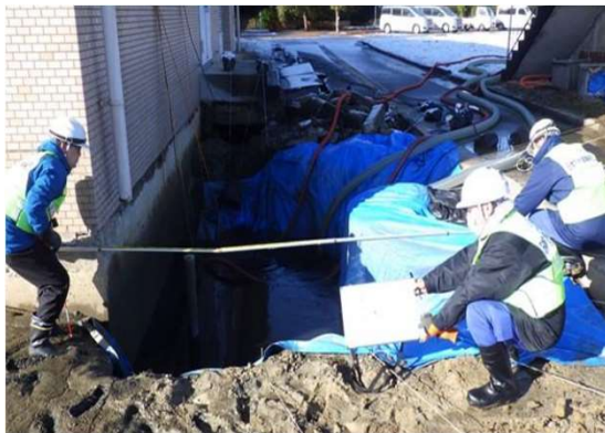
導水渠破断部の仮排水(七尾市西部T)
