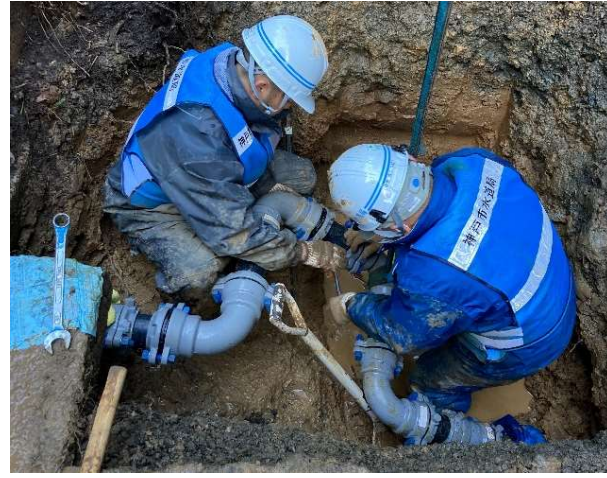
穴水町導水管復旧工事 (神戸市水道局)
