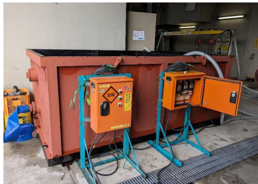
仮設電源盤、仮設沈殿処理槽の設置(能登町新港P)
