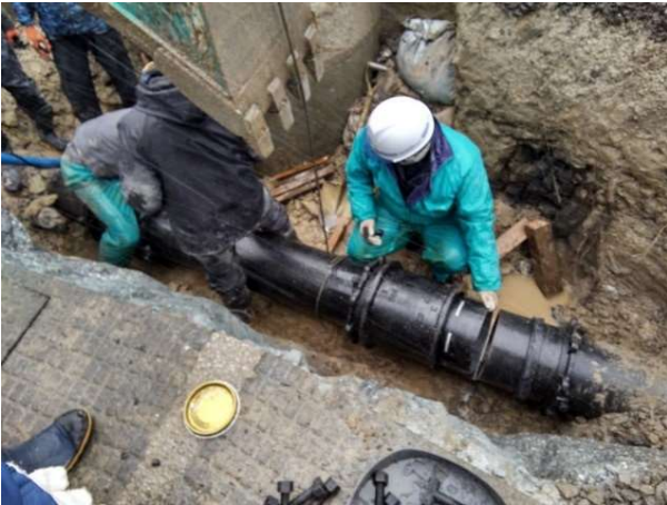
輪島市送水管復旧工事 (横浜市水道局)
