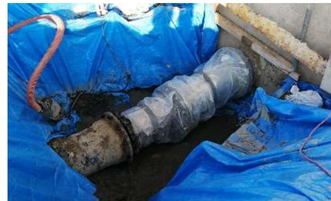
仮設圧送管の設置(能登町新港P)
