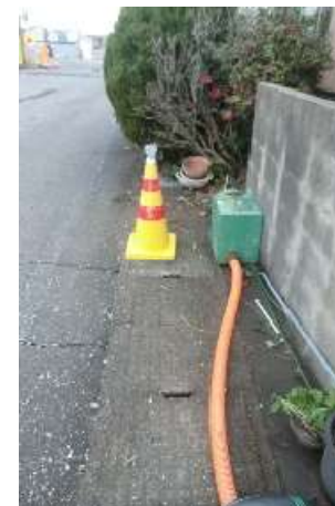
真空式仮設排水管の設置(羽咋市)
