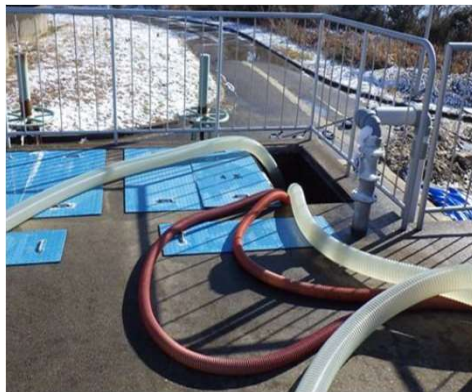
導水渠破断部の仮排水(七尾市西部T)
