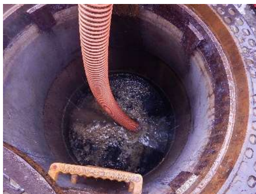
バキューム吸引(津幡町)
