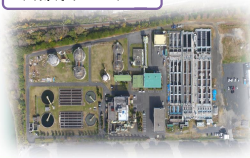
西部浄化センター
