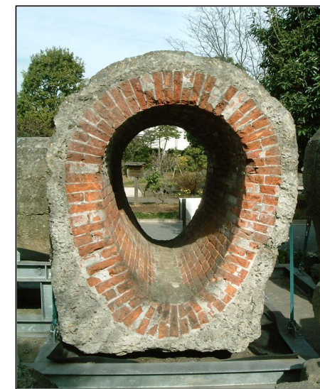
横浜市レンガ製下水管きよ (明治14年)
