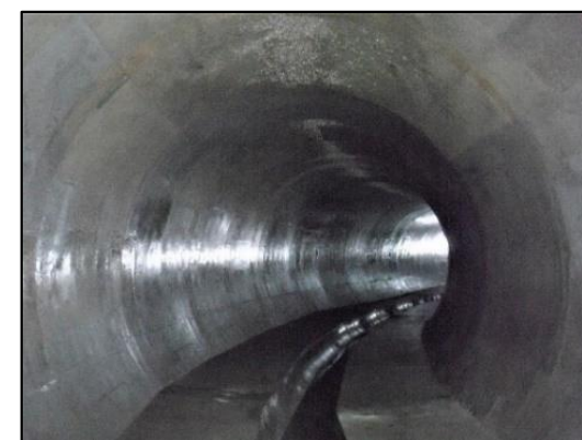
雨水滞水池(堀川左岸雨水滞水池)
