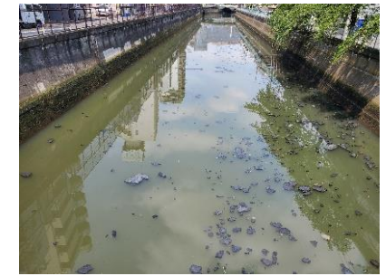
スカムの状況② (R3. 7. 12 御成橋上流)
