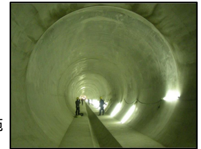
堀川右岸雨水滞水池
