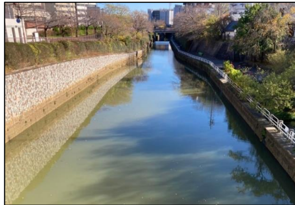
白濁化の状況【堀川（名古屋市）】
