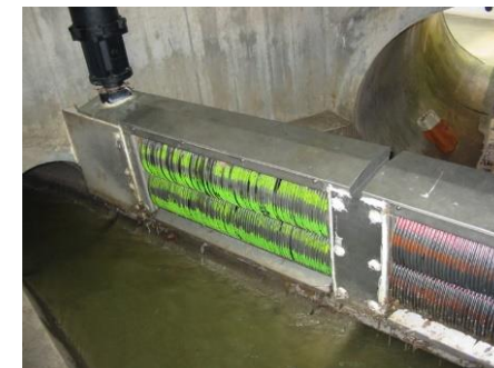
ディスクスクリーン設置状況
