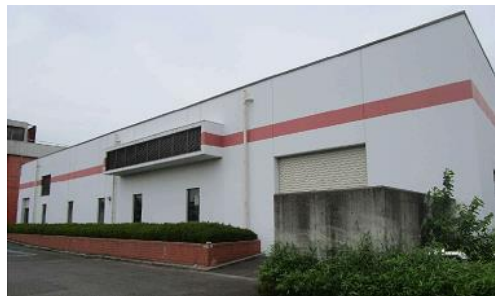
①雨天時貯留池の整備
