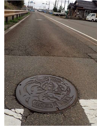
【羽咋市】 対策：過剰間隙 水圧発生抑制工法
