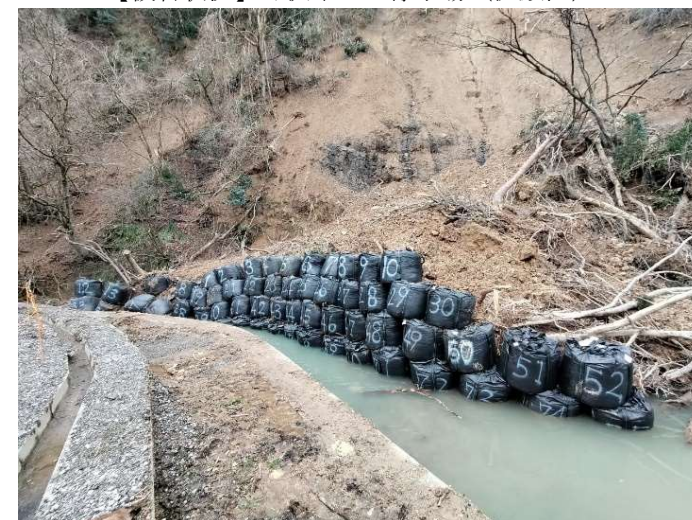
【応急復旧】珠洲市大谷浄水場（河道仮復旧）
