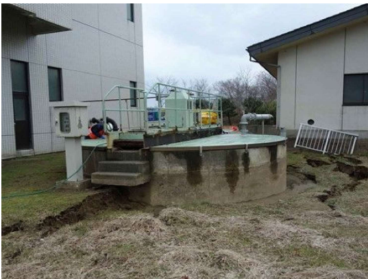
重力濃縮槽浮上り(羽咋市羽咋T)
