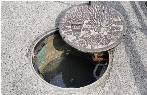
下水道管路の滞水状況
