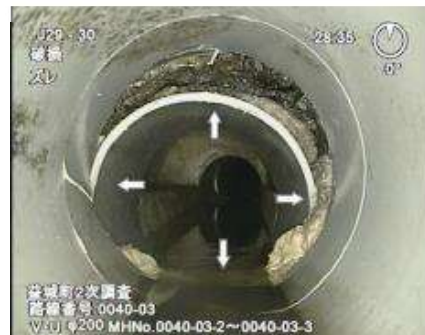
管の破断やずれで流下機能なし(益城町の例)
