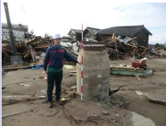
人孔浮上(珠洲市)
