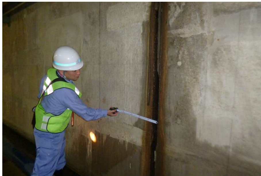
反応タンク継ぎ目部破損による漏水
