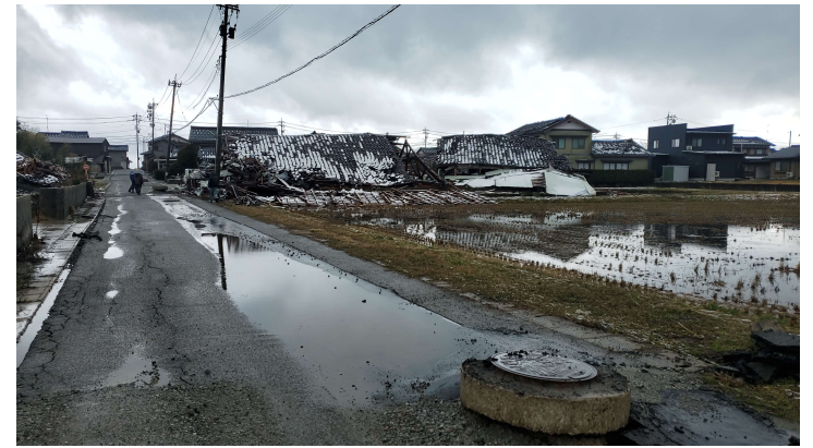
圧送管の破損が原因と想定される路面変状
