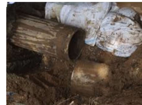
管の破断やずれで流下機能なし(益城町の例)
