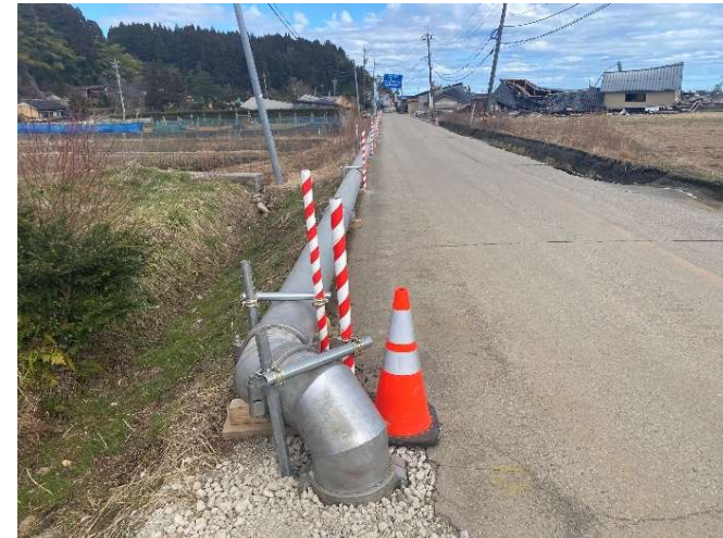
珠洲市 送水管復旧
