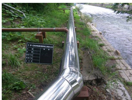
露出配管時の保温材設置（他都市事例）
