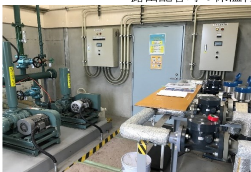
機械室内配管への保温材巻き付け（標茶町）
