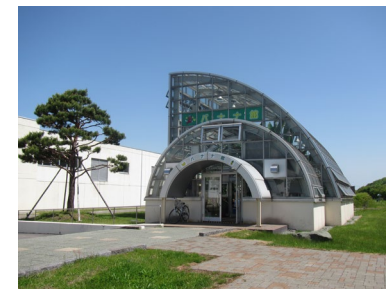
下水資源多目的活用センター (通称：バナナ館)
