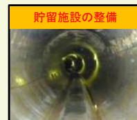
貯留施設の整備
