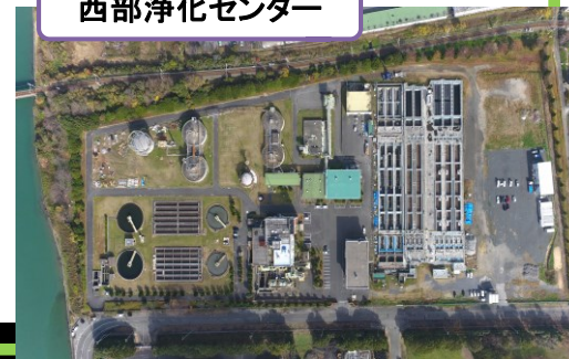
西部浄化センター
