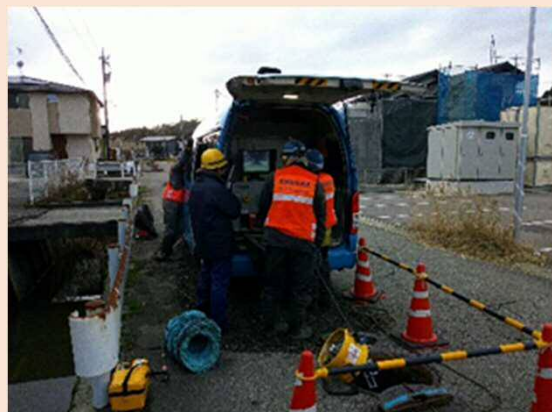
【下水管内調査】
