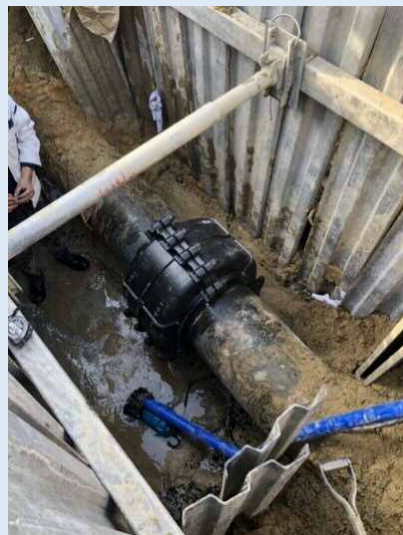
【配水管の漏水補修】
