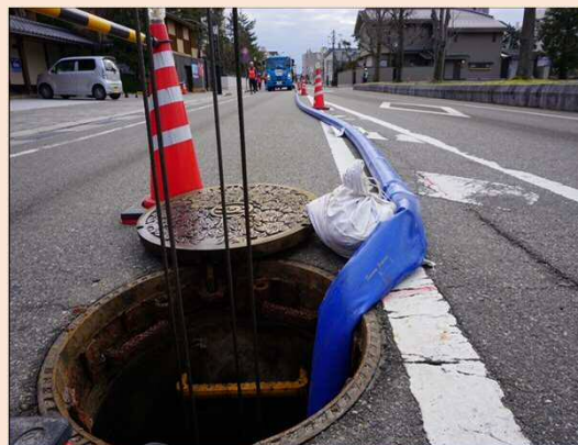
【下水管閉塞箇所へのバイパス管による応急対応】
