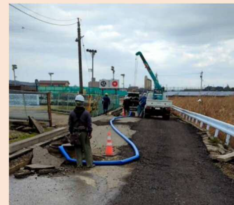
【下水管閉塞箇所へのバイパス管による応急対応】
