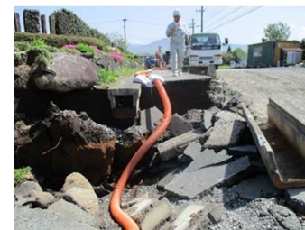
【必要最小限度工事の状況(仮設配管の場合)】
