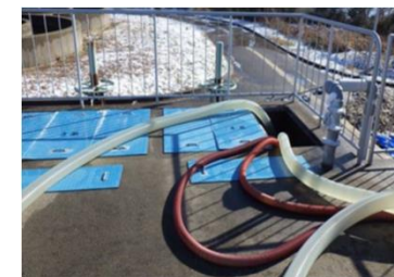
【必要最小限度工事の状況(仮設配管の場合)】
