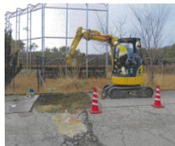
応急復旧作業風景(石川県組合) 1
