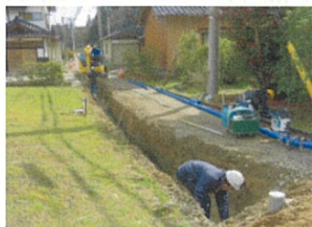
応急復旧作業風景(七尾市組合) 1
