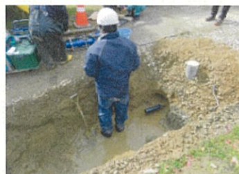
応急復旧作業風景(七尾市組合) 3
