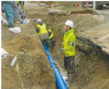
応急復旧作業風景(小松組合) 1 3
