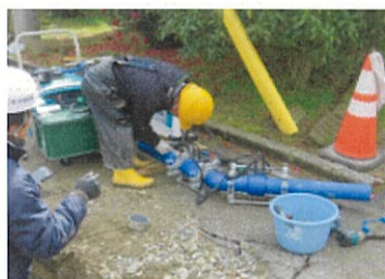
応急復旧作業風景(七尾市組合) 4
