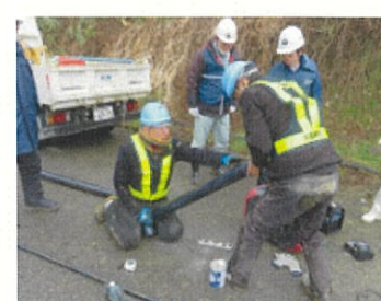
応急復旧作業風景(橋本市組合) 7
