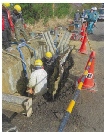
応急復旧作業風景(名古屋市組合) 3
