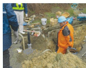
応急復旧作業風景(橋本市組合) 3
