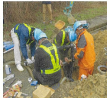
応急復旧作業風景(橋本市組合) 10
