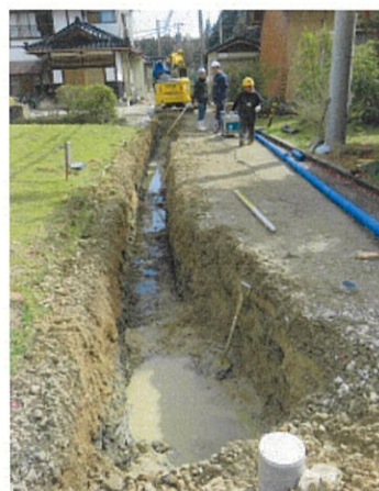
応急復旧作業風景(七尾市組合) 6
