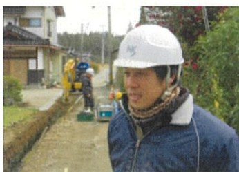
応急復旧作業風景(七尾市組合) 7
