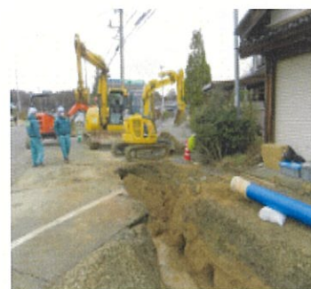
応急復旧作業風景(小松組合) 8
