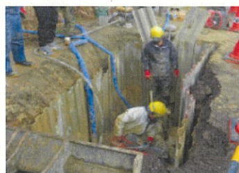
応急復旧作業風景(名古屋市組合) 1
