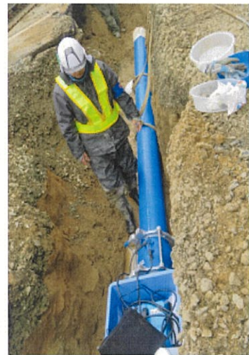
応急復旧作業風景(小松組合) 1 5
