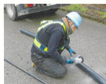
応急復旧作業風景(橋本市組合) 2
