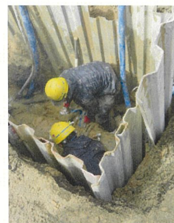
応急復旧作業風景(名古屋市組合) 5
