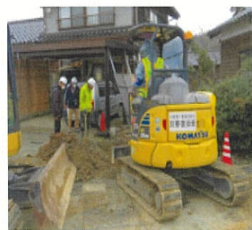
応急復旧作業風景(小松組合) 6
