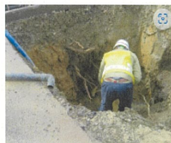
応急復旧作業風景(石川県組合) 5
