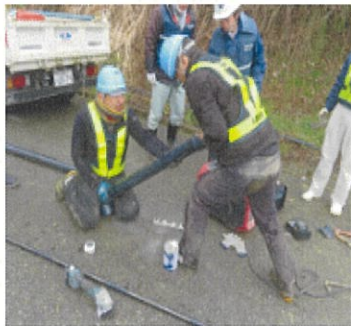
応急復旧作業風景(橋本市組合) 8
