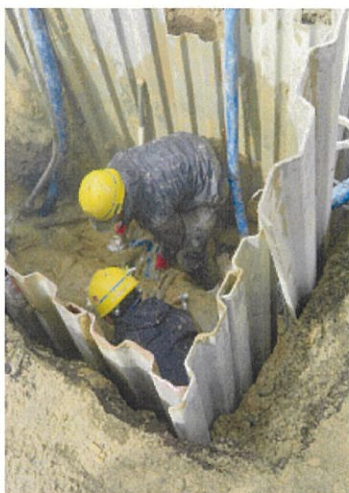
応急復旧作業風景(名古屋市組合)6
