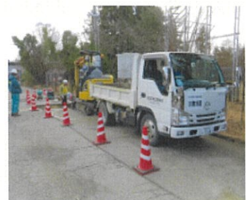
応急復旧作業風景(石川県組合) 3
