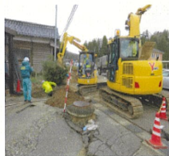
応急復旧作業風景(小松組合) 5
