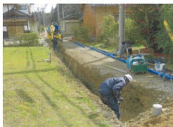
応急復旧作業風景(七尾市組合) 2
