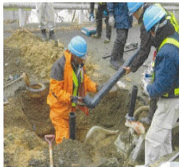
応急復旧作業風景(橋本市組合) 9
