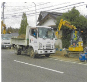
応急復旧作業風景(小松組合) 1
