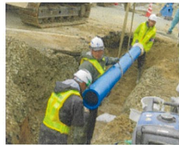
応急復旧作業風景(小松組合) 1 2
