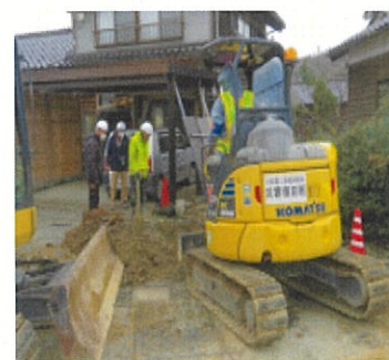
応急復旧作業風景(小松組合) 7
