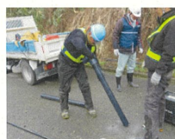
応急復旧作業風景(橋本市組合) 6
