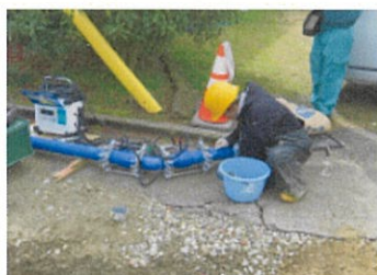
応急復旧作業風景(七尾市組合) 5
