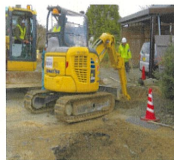
応急復旧作業風景(小松組合) 4
