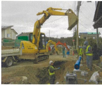
応急復旧作業風景(小松組合) 1 0
