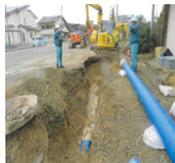
応急復旧作業風景(小松組合) 3
