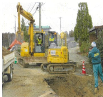
応急復旧作業風景(小松組合) 2
