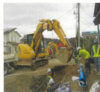
応急復旧作業風景(小松組合) 9
