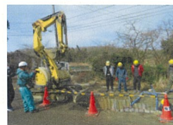
応急復旧作業風景(名古屋市組合) 2
