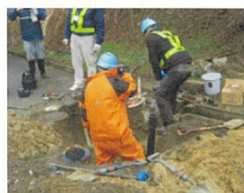
応急復旧作業風景(橋本市組合) 1
