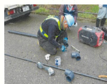
応急復旧作業風景(橋本市組合) 5
