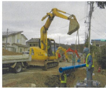
応急復旧作業風景(小松組合) 1 1
