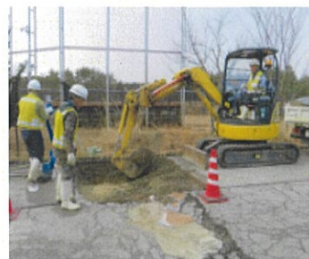
応急復旧作業風景(石川県組合) 2
