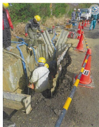
応急復旧作業風景(名古屋市組合) 4
