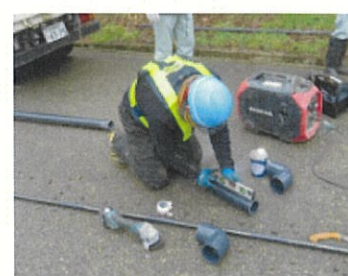
応急復旧作業風景(橋本市組合) 4
