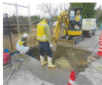
応急復旧作業風景(石川県組合) 4
