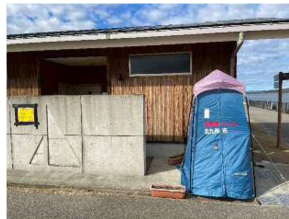
マンホールトイレの設置(七尾市)
