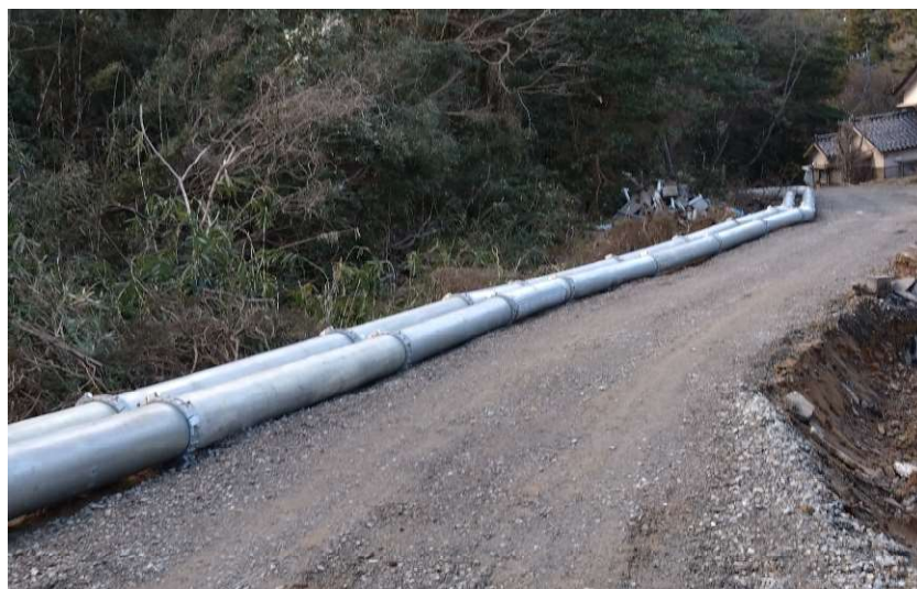
輪島市 送水管復旧
