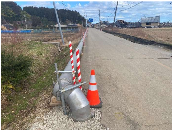
珠洲市 送水管復旧
