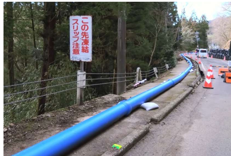
輪島市 配水管復旧
