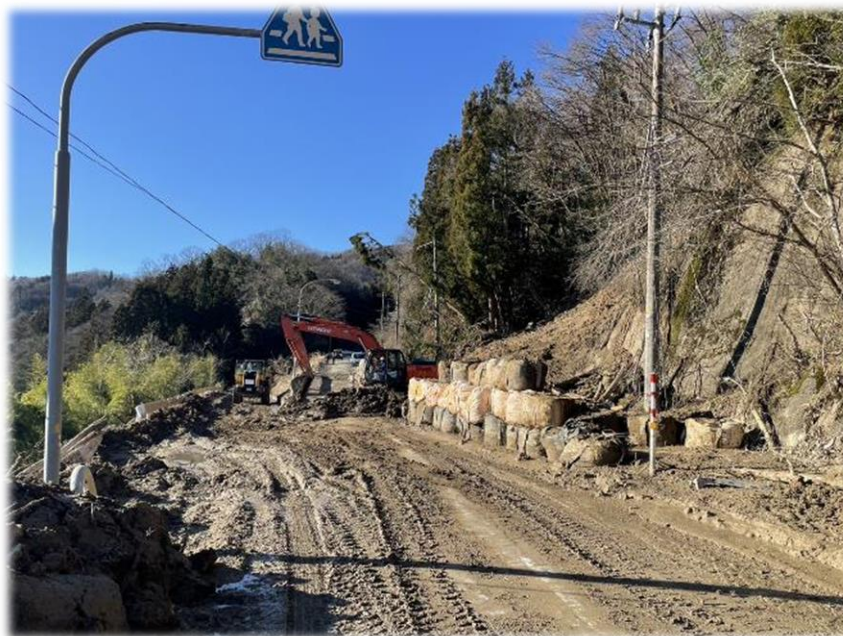
県道の復旧作業状況（輪島市内）
