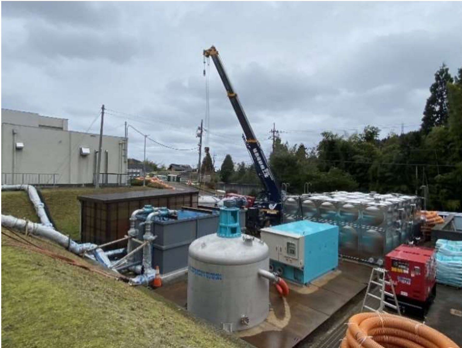
【応急復旧】 珠洲市宝立浄水場（可搬式浄水装置）
