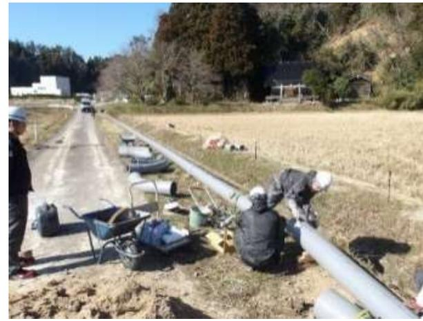
下水を集約し処理場へ送る圧送管の被災現場（珠洲市）
