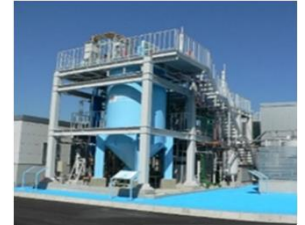
リン回収施設
