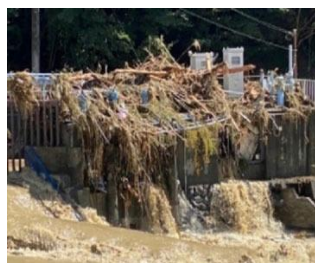
おきつがわしゅすいこう 興津川取水口の被災状況 (令和4年 静岡県静岡市)
