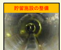
貯留施設の整備
