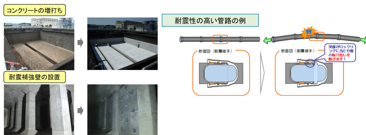
図 1－1 水道施設の耐震化例
