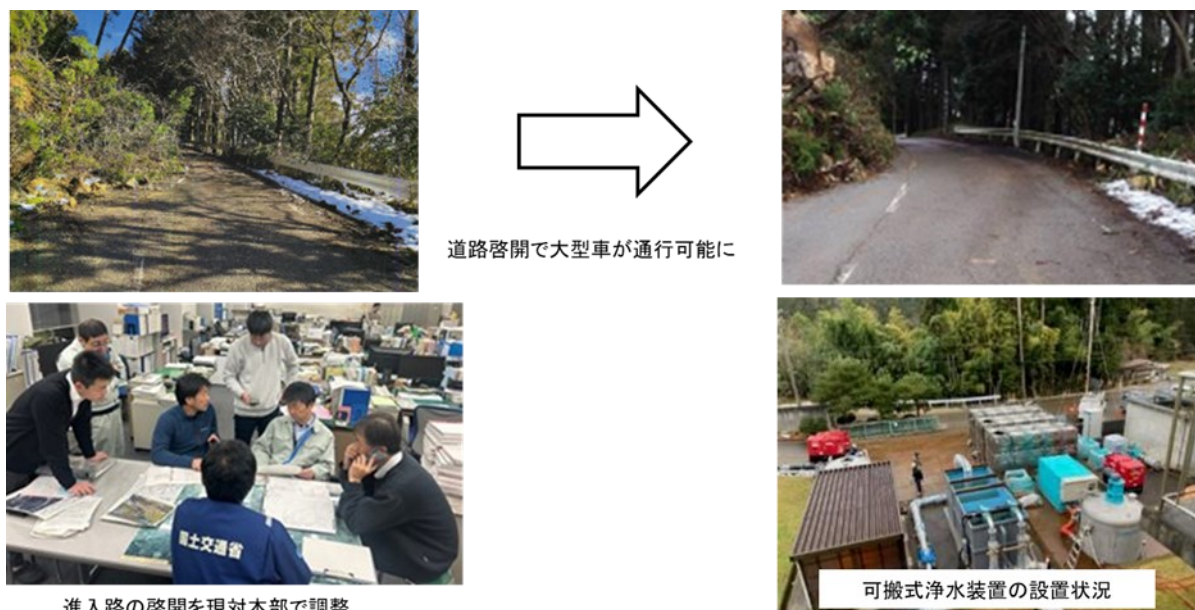
図5-2 TEC-FORCE（水道支援チーム）による道路啓開に向けた調整
