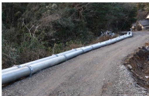
図 5 - 6 仮設配管の活用
