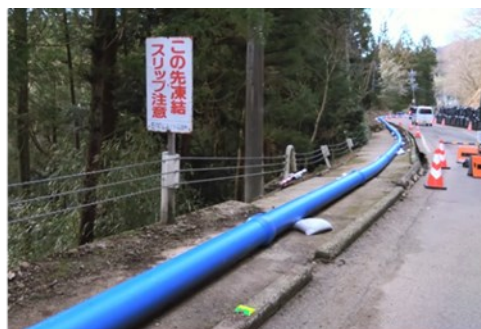
青森市 配水管復旧
