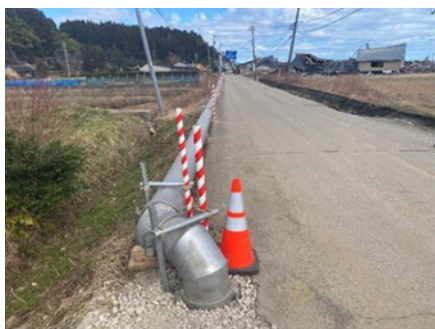
珠洲市 送水管復旧
