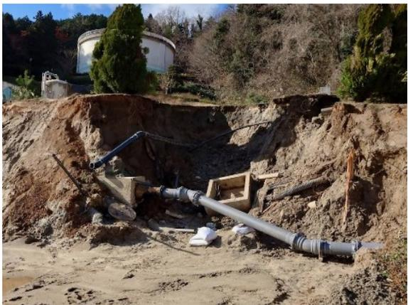
浄水場内の配管損傷（七尾市）
