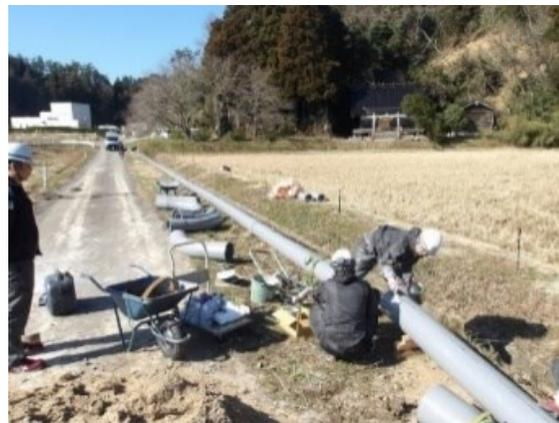
下水を集約し処理場へ送る圧送管の被災現場（珠洲市）
