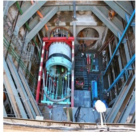
道路を開削せず管路を布設する推進工法
