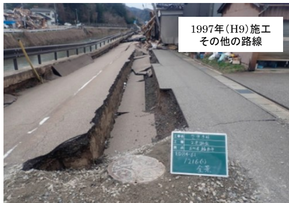
旧指針による設計・施工
