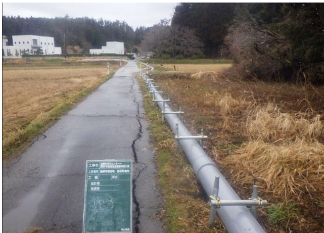
仮設圧送管 布設状況
