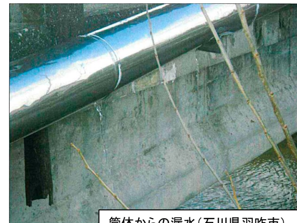
管体からの漏水(石川県羽咋市)
