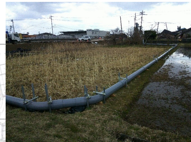
仮設圧送管 布設状況
