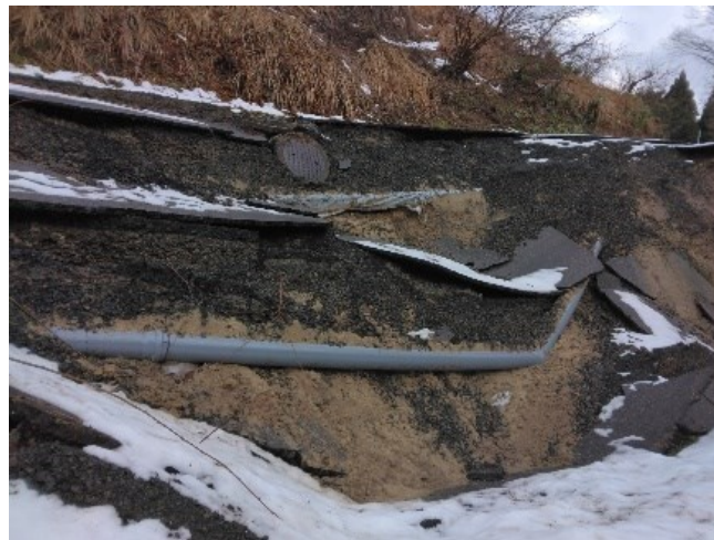
水道水を配水する拠点となる配水池に送る送水管の被災（輪島市送水管）
