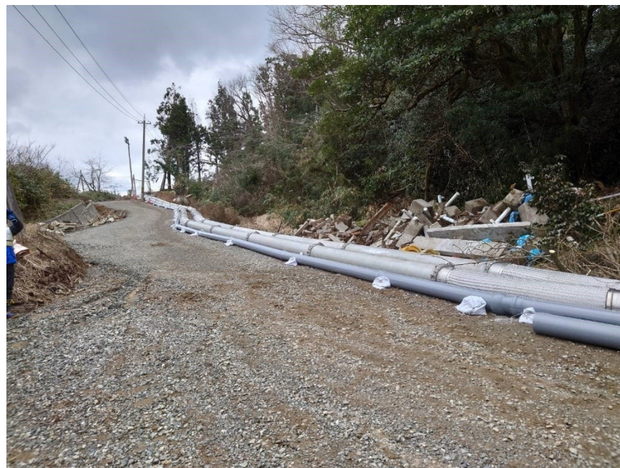
道路啓開後に仮設配管を敷設
