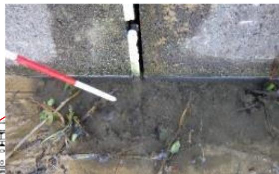
1系OD槽目地の隙間・ズレによる汚水の漏れ
