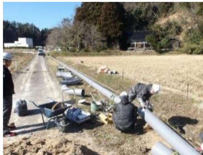
区域の下水を集約し処理場へ送る圧送管の被災（珠洲市熊谷ポンプ場からの圧送管）
