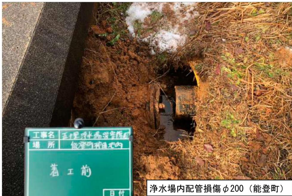
浄水場内配管損傷φ200 (能登町)
