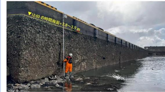
鹿磯漁港の防潮堤に固着した生物遺骸が示す隆起の様子。人が持っている標尺の長さは5m
