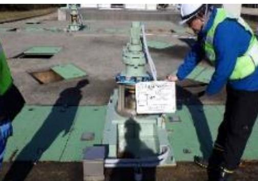
1系終沈が傾斜(1.1度)
