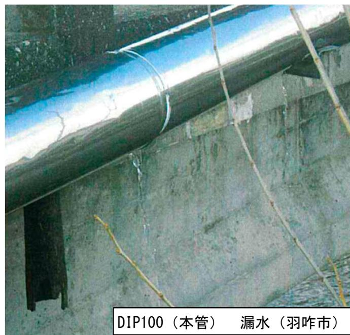
DIP100 (本管) 漏水 (羽咋市)
