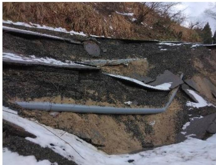
水道水を配水する拠点となる配水池へ送る送水管の被災（輪島市送水管）
