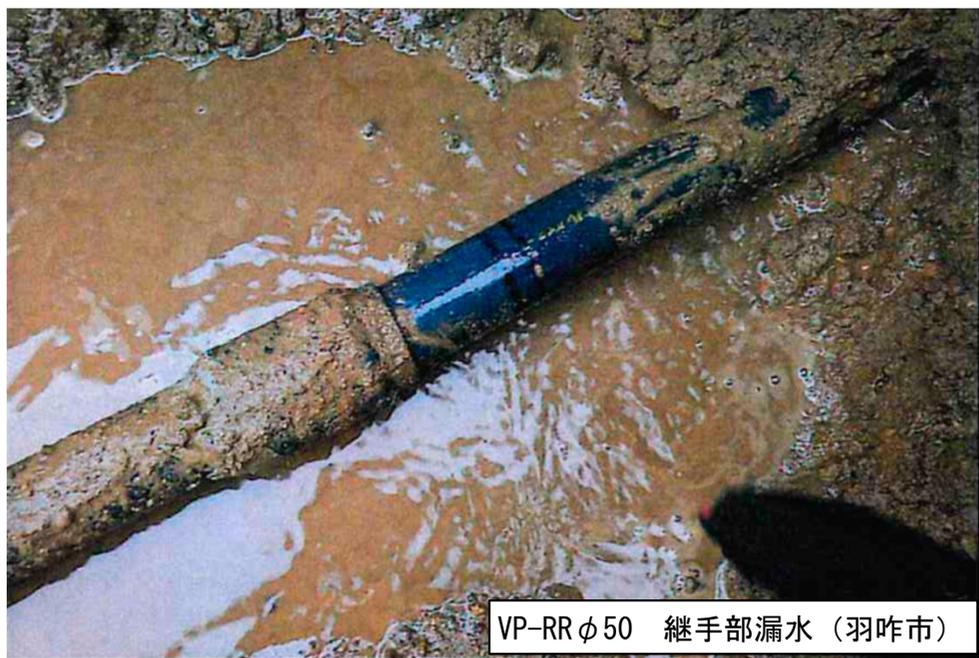
VP-RRφ50 継手部漏水(羽咋市)
