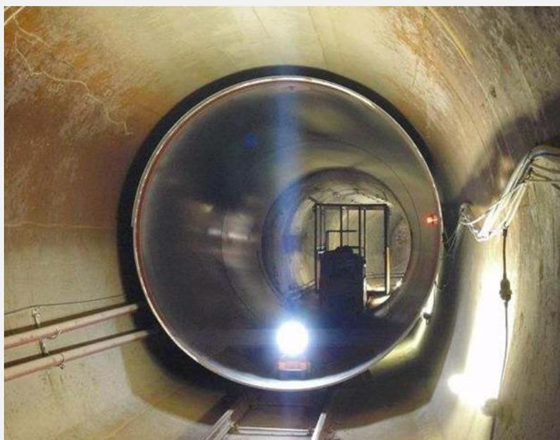
送水幹線の再整備（鋼管挿入）
