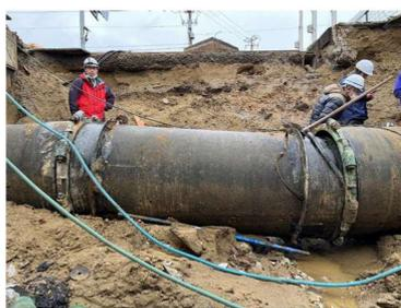
送水管の被害（七尾市）
