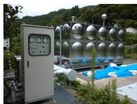
○輪島市【応急対応事例】 美谷地区に送水ポンプ施設を設置
