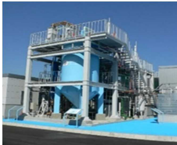
リン回収施設
