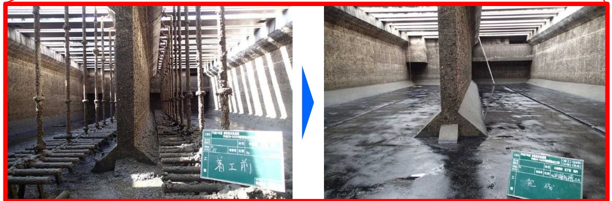
既存施設の有効活用事例(調整池へ改造)
