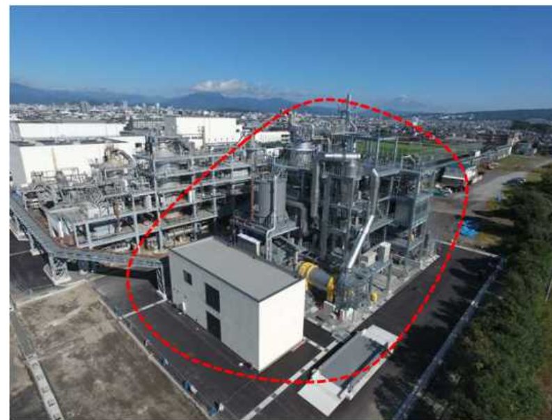
中島浄化センター汚泥燃料化施設
