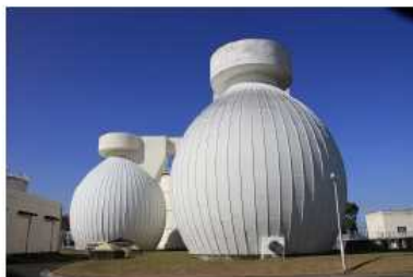
▲ 消化槽（南部浄化センター）
