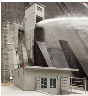
【発電設備の新設・増強】
