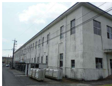
【現状施設の例(庁舎)】
