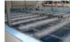
超微細散気装置導入による省エネ化 (〇〇〇t-CO 2 削減)
