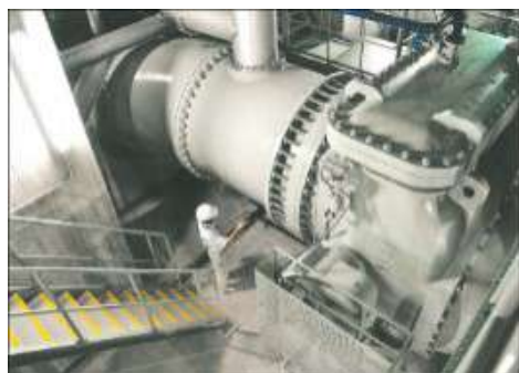
雨水ポンプの整備
