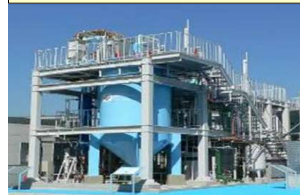
リン回収施設
