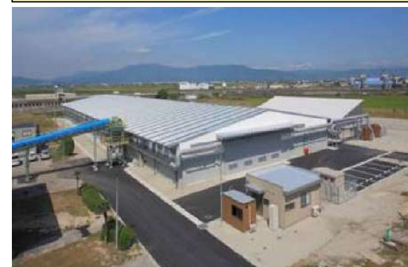
汚泥コンポスト化施設
