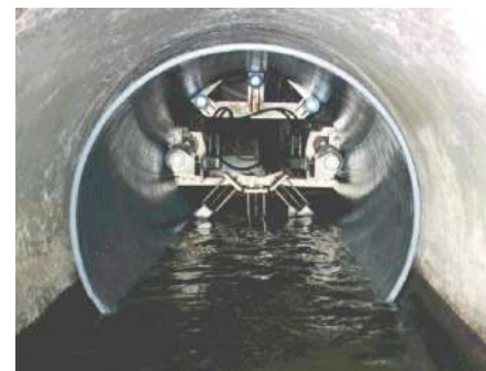
更生工法による老朽化対策
