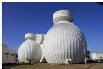
▲ 消化槽（南部浄化センター）
