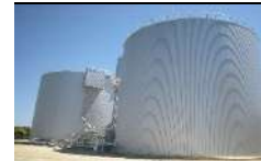
汚泥消化施設の導入によるバイオガス発電 (〇〇〇〇t-CO 2 削減)
