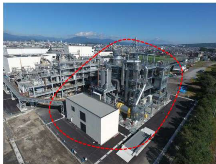
中島浄化センター汚泥燃料化施設
