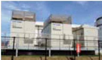
写真 消化ガス発電設備（燃料電池）
