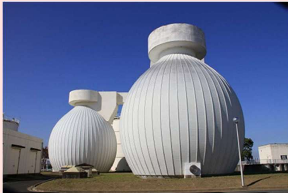
南部浄化センター 卵型消化槽
