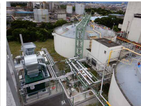
写真 西部浄化センター
