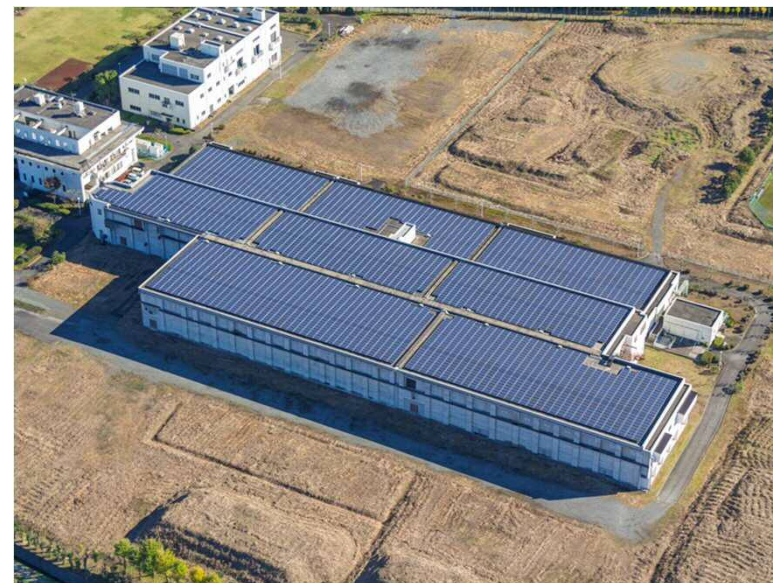
写真 東部浄化センター
