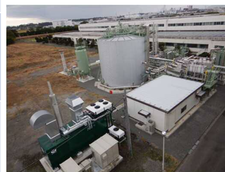
写真 東部浄化センター
