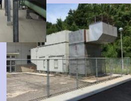
②高所等の点検
