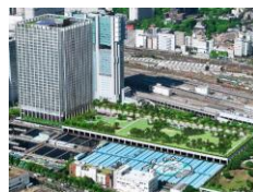
地域の防災拠点として避難者を受け入れ
